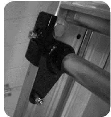
6 "Vergrendelde positie". De schroefkoppen rusten op de blauwe grendels.
