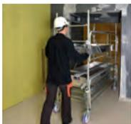
**L'AC SE DÉPLACE TRÈS FACILEMENT SUR LE CHANTIER EN POSITION CHARIOT. PASSAGE DES PORTES DE 0,83 M.**
