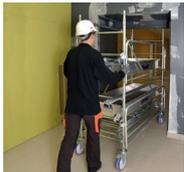
**2** L'AC SE DÉPLACE TRÈS FACILEMENT SUR LE CHANTIER EN POSITION CHARIOT. PASSAGE DES PORTES DE 0,83 M.
