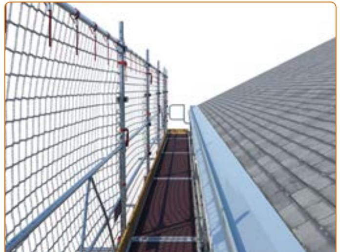
Un dispositif «anti-chutes» est mis en place le long de la pente de toit : un filet de sécurité ultra résistant (selon la norme NF EN 1263) sur une hauteur de 2 m, en extrémité un garde-corps épouse les avancées du toit.
