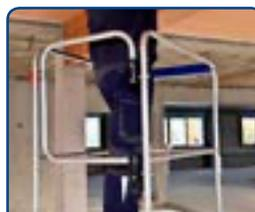
**Garde-corps avec portillon pour une protection permanente et incontournable**
