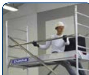
• Grâce au système de fixation Décllic mis au point par Duarib, les diagonales et les lisses du DOCKER2 se verrouillent automatiquement.
