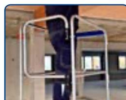
**Garde-corps avec portillon pour une protection permanente et incontournable**
