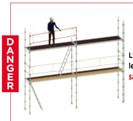
L'opérateur pose le garde-corps sans aucune protection.
