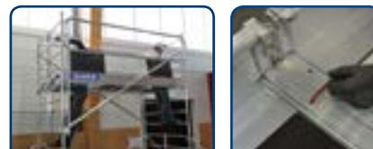
• Fixation des 2 planchers par crochets imperdables.
